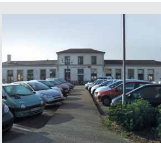
Gare de Guingamp (Source : EPF)
