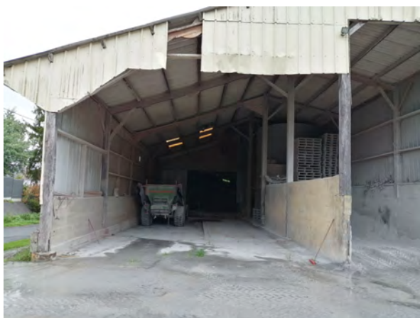
Intervention de l'EPF pour la préemption d'un bien.
