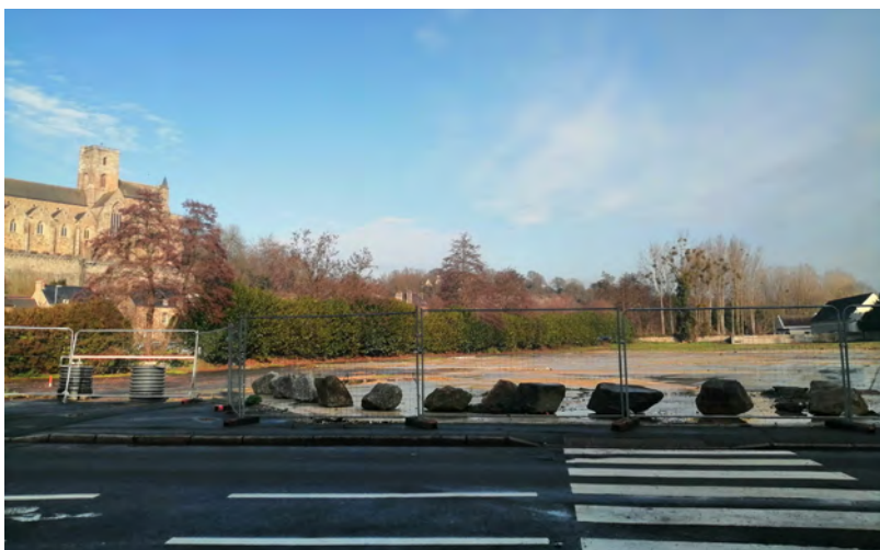
Désamiantage, curage et déconstruction d'un ancien garage.
