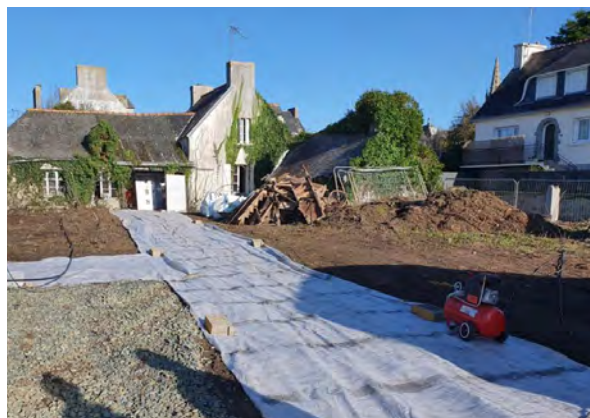
Déconstruire pour réaliser de nouveaux logements.
