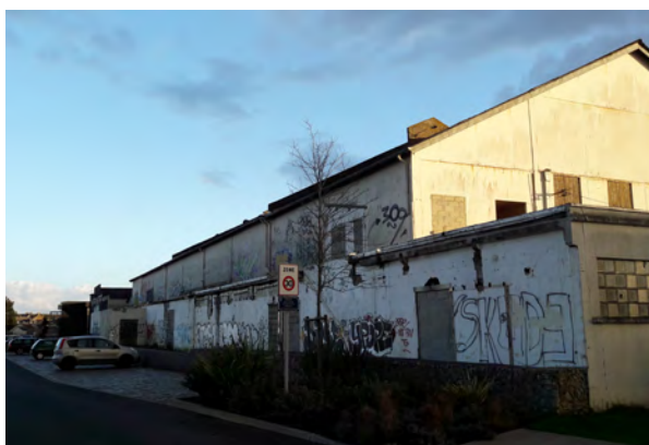
Pilotage des travaux de déconstruction et dépollution d'une ancienne usine.
