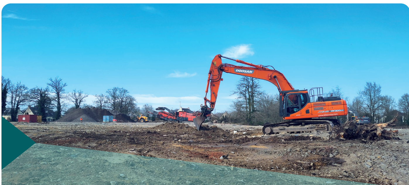
LOCALISATION : MALANSAC (56) : DÉCONSTRUCTION PAR EPFB D'UN ANCIEN SITE INDUSTRIEL AGRO-ALIMENTAIRE POUR RENATURATION | CRÉDITS : EPF BRETAGNE
