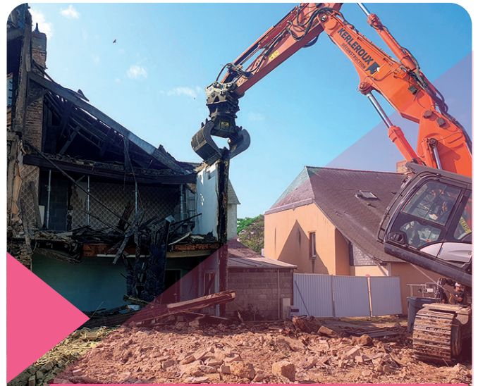
LOCALISATION : MORDELLES (35) : DÉMOLITION DE BÂTIS EPFB ET COMMUNAUX EN GROUPEMENT DE COMMANDE POUR RÉALISATION DE 15 LOGEMENTS DONT 5 LOCATIFS SOCIAUX | CRÉDITS : EPF BRETAGNE
