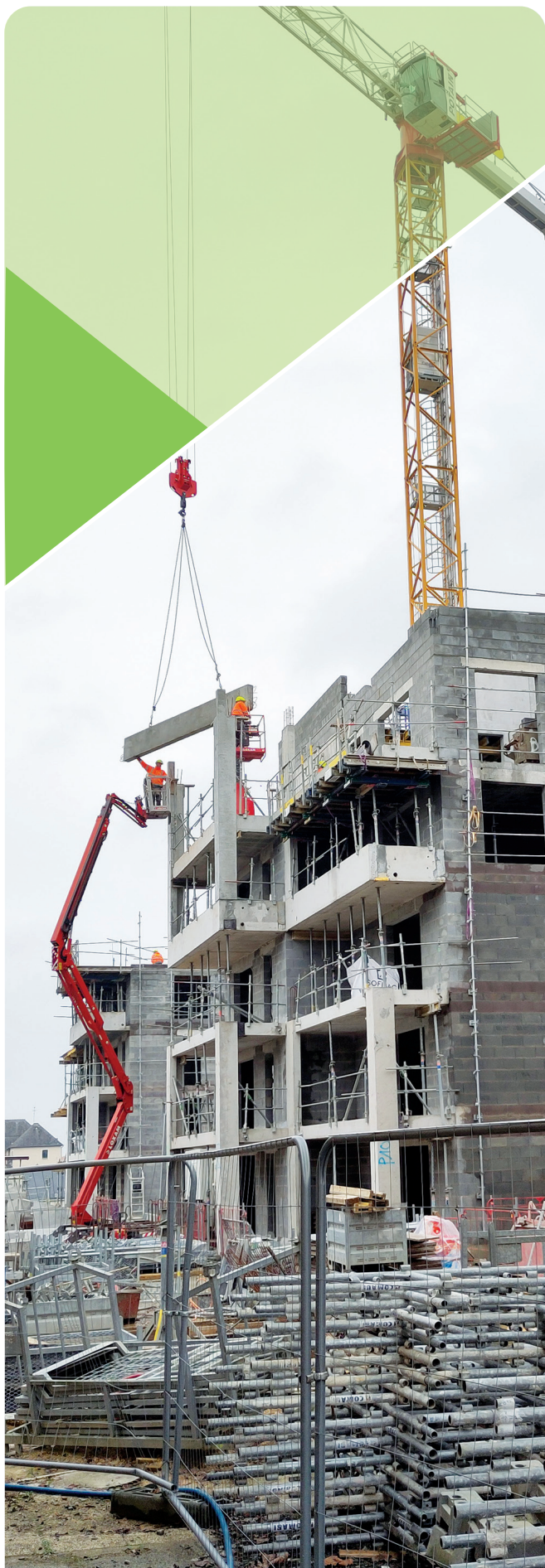
LOCALISATION : VITRÉ (35) : RÉALISATION DE 98 LOGEMENTS (DONT 28 LOGEMENTS LOCATIFS SOCIAUX) ET 7 COMMERCES SUR FONCIER EPFB PAR LE PROMOTEUR ARC | CRÉDITS : EPF BRETAGNE
