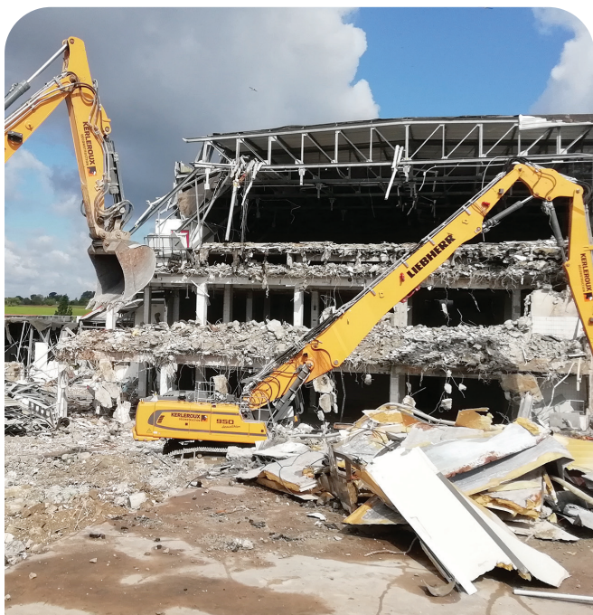
L'EPFB A ACQUIS L'ANCIENNE FRICHE GAD A LAMPAUL-GUIMILIAU (29) EN 2018. APRÈS DÉMOLITION PARTIELLE, LE SITE A ÉTÉ REVENDU À BRETAGNE LIN EN 2025 | CRÉDITS : EPF BRETAGNE
