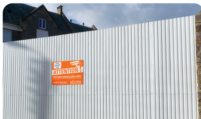
LOCALISATION : LORIENT (56) : FERMETURE ET VIDÉOSURVEILLANCE DE L'ANCIEN HÔPITAL DE BODÉLIO EN 2013 AVANT SA DÉCONSTRUCTION | CRÉDITS : EPF BRETAGNE
