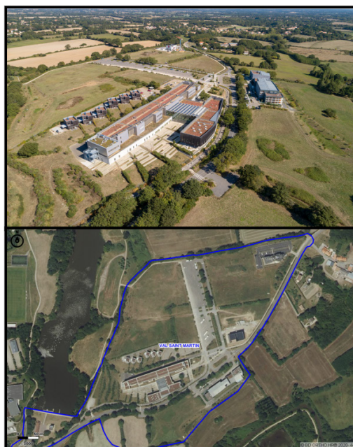
Zone d'Activités du Val-Saint-Martin (Pornic 44210)
