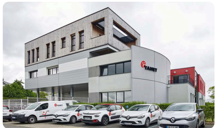
Surélévation d'un bâtiment existant, Saint-Herblain (44)
