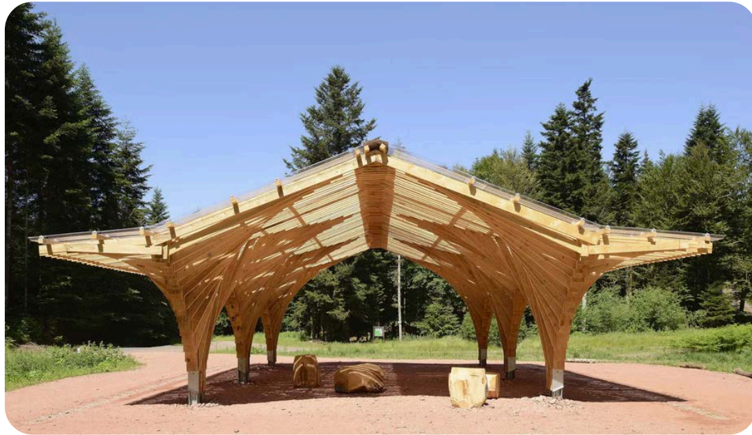
Halle à Bertrichamps, Chantier participatif (commune + 50 bénévoles) (54) Association Pierre Terre
