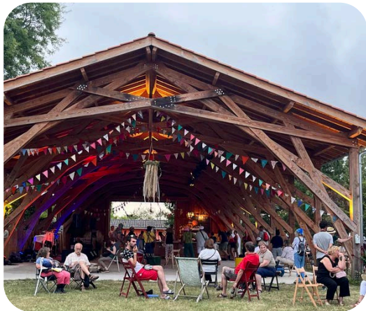
Co-construction d'un kiosque (32) Asso Pierre et terre
