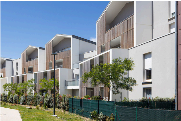
38 logements collectifs à Toulouse (31) @ARUA architectes
